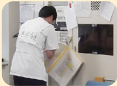
感知器が作動した場所を、確認し現場確認連絡を行う。 (1分以内)
